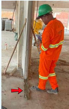
**Imagem 1** — Aplicação de argamassa ACIII na instalação do painel com a base.
