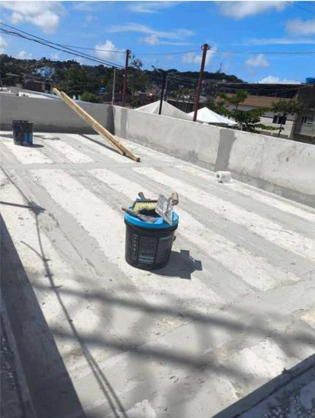
**Imagem 27 – Aplicação de tratamento de juntas em laje**
