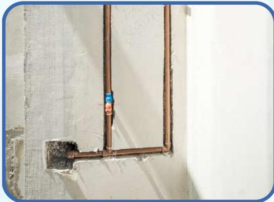
**Imagem 31— Instalação de dutos em painel Lightwall.**
