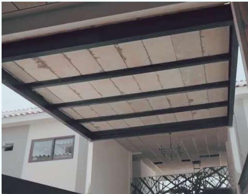
**Imagem 32 – Instalação de painéis em laje**
