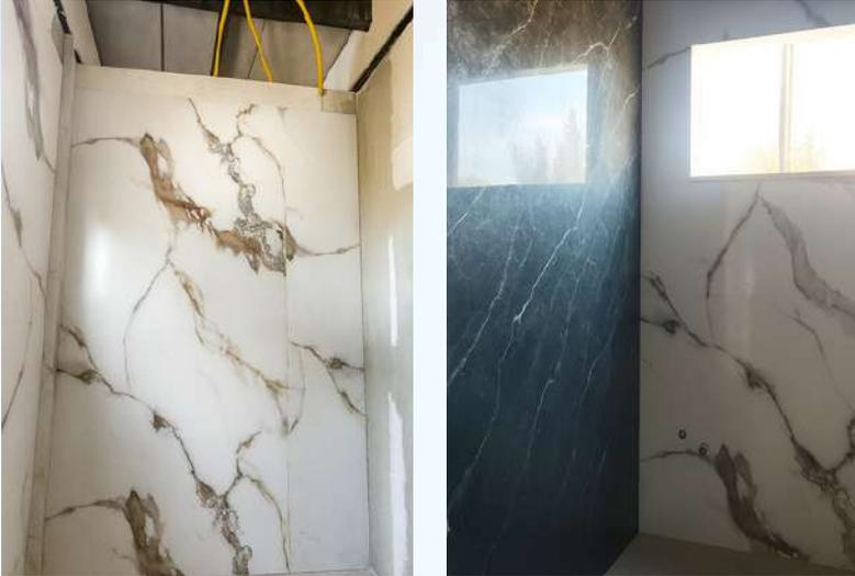
**Imagem 35 — Instalação de papel de parede/Formica.**
