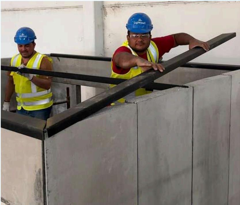
**Imagem 33 – Instalação de perfil “U” para amarração dos painéis Lightwall.**
