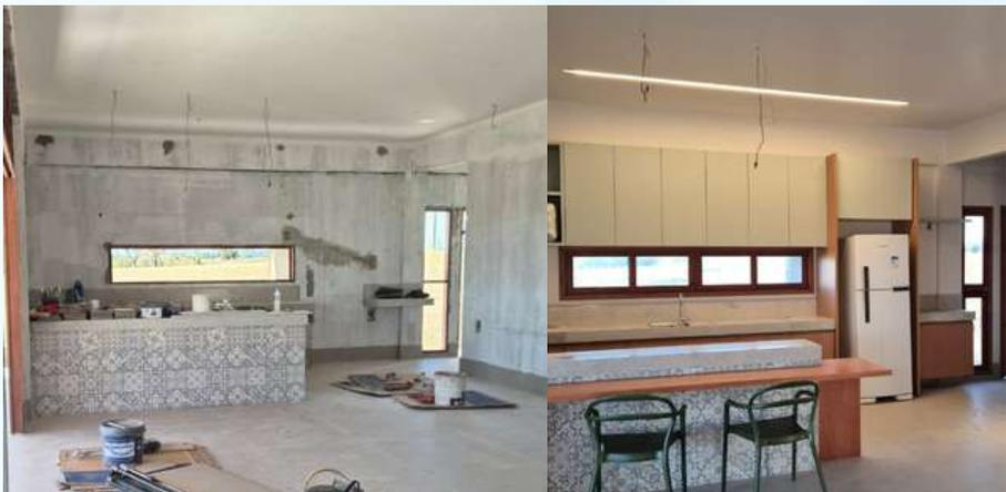
**Imagem 34 – Pintura em paredes de Lightwall**
