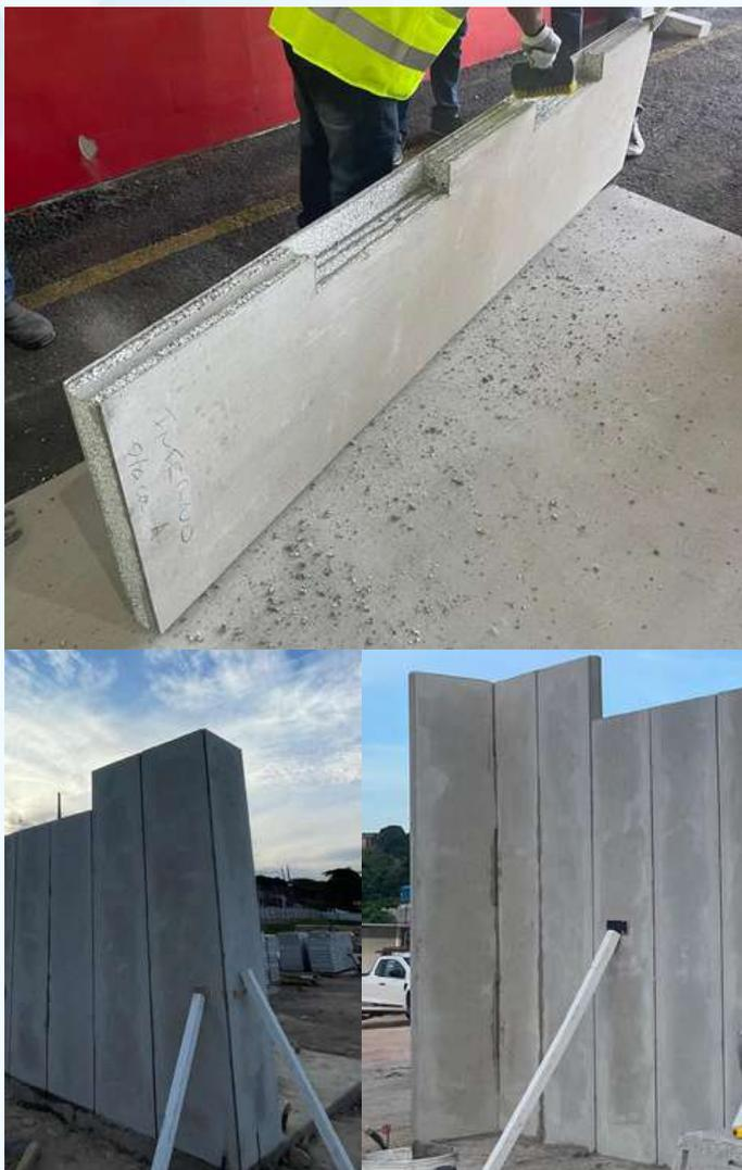
**Imagem 9 — Ligação do tipo trama embutida entre painéis Lightwall®**
