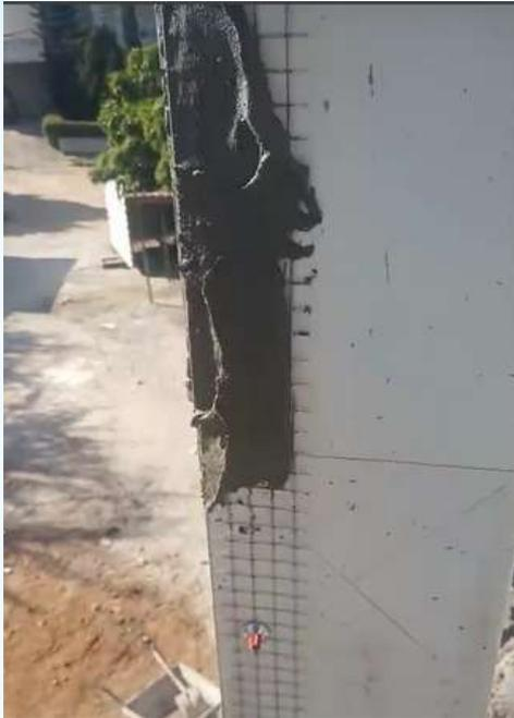
**Imagem 16** — Aplicação da argamassa de assentamento ACIII sobre a tela de alvenaria.
